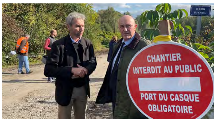
3,4 millions d'euros hors taxes de travaux sont prévus pour les travaux du tronçon entre Voyennes et Saint-Simon.
